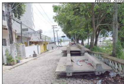
Avenida sem obras. No local apenas equipamento para contenção da encosta
